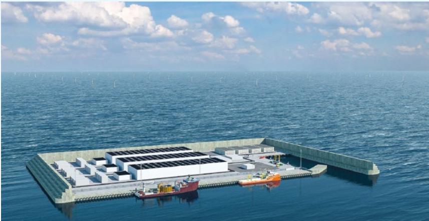
Auf einer künstlichen Insel errichtet wird der Energie-Hub Strom von Hunderten Offshore-Windkraftwerken sammeln und an Länder rund um die Nordsee liefern.
