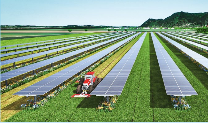
In der Agro-Photovoltaik-Anlage der EWS Consulting werden gleichzeitig Solarstrom und Nahrungsmittel geerntet und der Flächenertrag auf bis zu 160 % erhöht.
